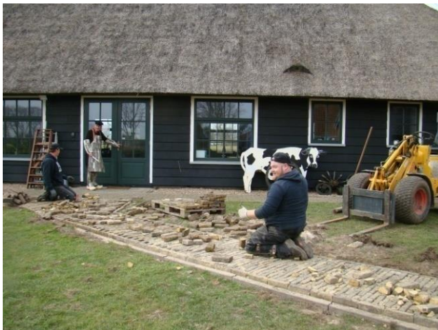
Aanleg van het straatje met boerengeeltjes uit Dedgum (bij Bolsward) door medewerkers van Ten Brinke bestratingen
