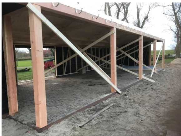
Februari 2021, het vorderen van de bouw van de rijtuigendoos door De Vries Houtbouw. Rondom de rijtuigendoos, bij de dichte wanden, is een schelpenpad van 60 cm breed aangelegd.
